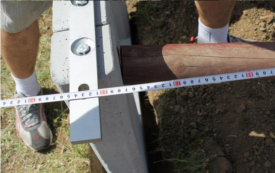
Sobald der Rahmen eingeebnet ist, füllen Sie die Löcher mit Erde aus dem Aushub auf und verdichten sie gründlich mit Holzdübeln. Es ist sehr wichtig, den Boden nach dem Einfüllen von etwa 10 cm schichtweise zu verdichten.
